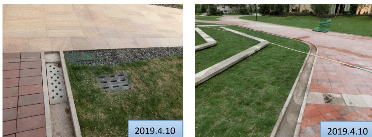
本项目道路旁雨水口
