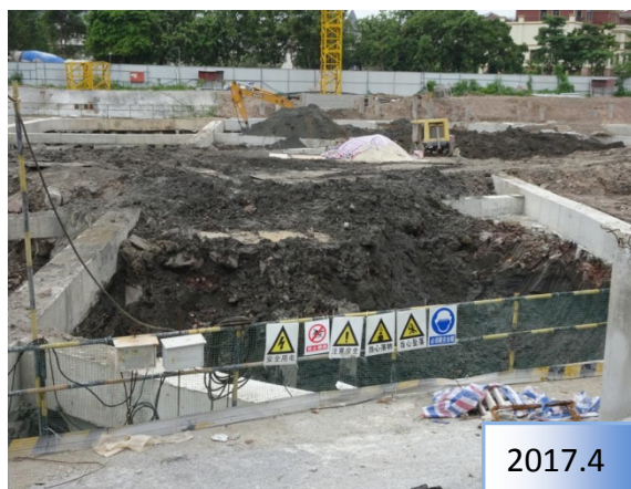
施工期，南面基坑开挖裸露地表
