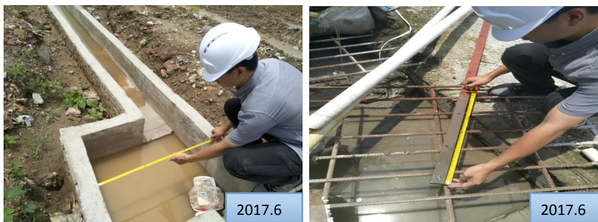
图 4-3 水土保持临时措施影像照片
