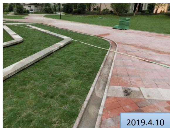
本项目道路旁排水沟
