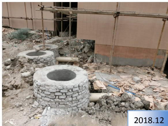
施工期, 管线沟槽开挖裸露地表
