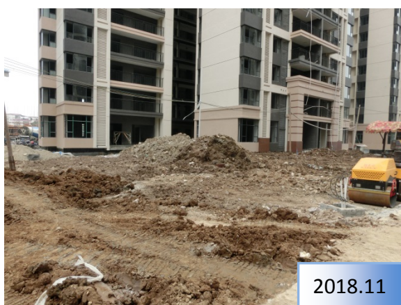
施工期, 区内道路建设裸露地表
