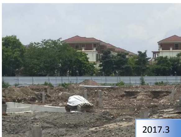
施工期, 南面裸露地表
