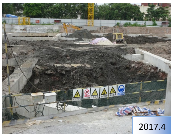
施工期, 南面基坑开挖裸露地表
