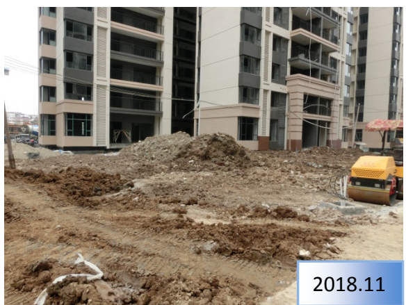
施工期，区内道路建设裸露地表
