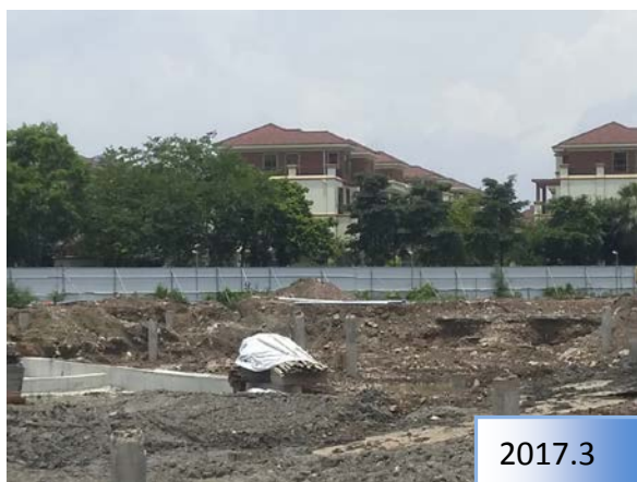
施工期，南面裸露地表
