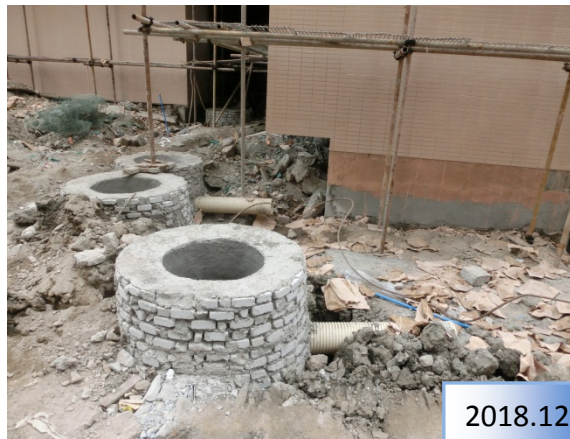
施工期，管线沟槽开挖裸露地表
